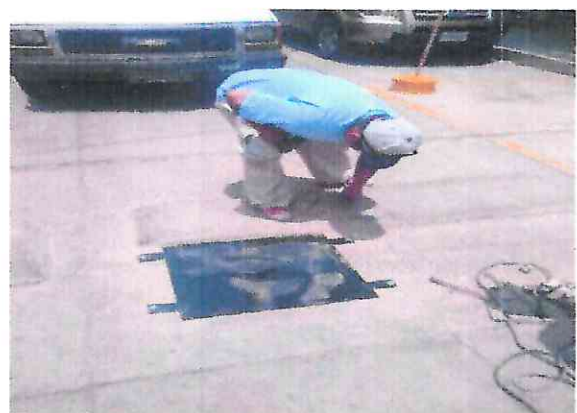
Calle 1 de Mayo (drenaje)
