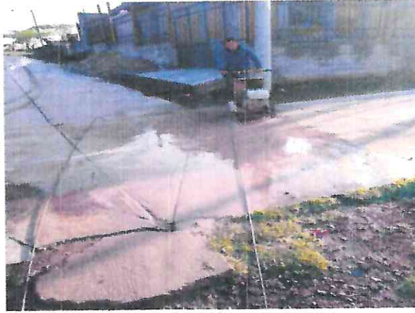
Corte de concreto para conexión Drenaje, "El Mezquitillo"
